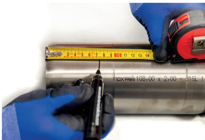
Figure 28 – Marquage de la profondeur d'emboîtement à l'aide d'un ruban de mesure
