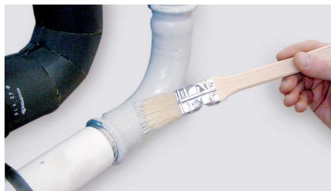
Figure 42 – Revêtement des raccords et des tubes avec une couche primaire.
