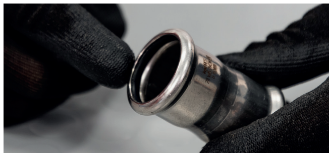
Figure 35 – Vérification de la bague d'étanchéité
