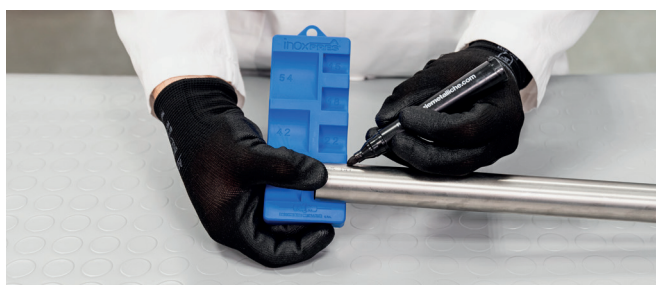
Figure 30 – Marquage de la profondeur d'emboîtement
