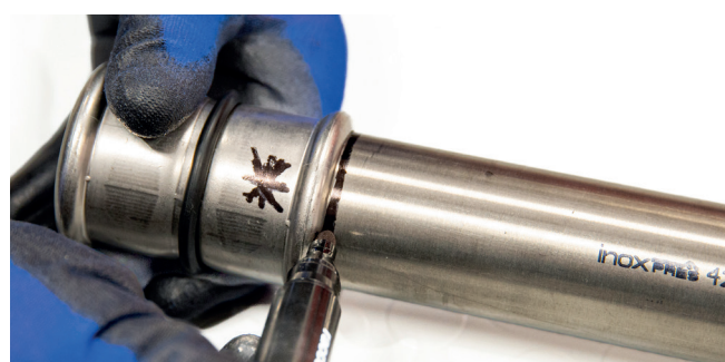
Figure 32 – Marquage de la profondeur d'emboîtement à l'aide d'un raccord
